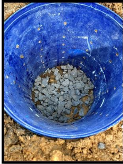
Gambar 4. Ember cat yang telah ditanam ke dalam lubang diberikan lapisan kerikil
