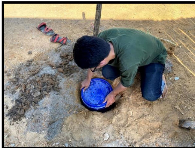
Gambar 5. Proses penutupan ember cat yang telah ditanam ke dalam lubang
